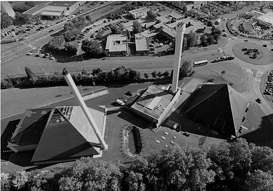
Figure 1 : chaufferie urbaine de Mons-en-Barœul
